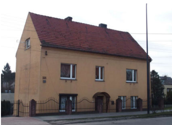
budynek mieszkalny – ul. I. Daszyńskiego 221
