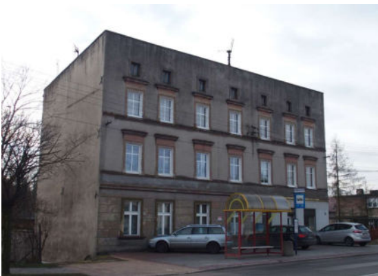
budynek mieszkalny – ul. I. Daszyńskiego 227
