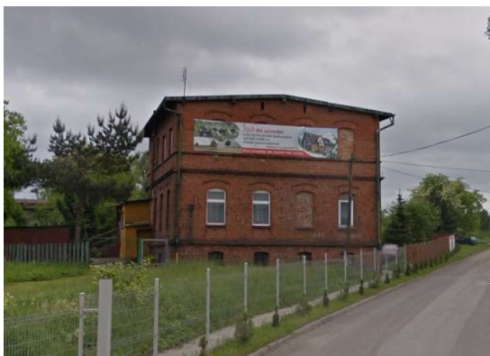
Budynek mieszkalny – ul. Stara Cegielnia 11
