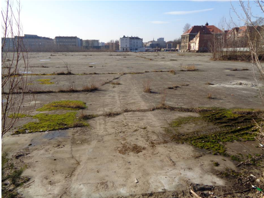
Fot. 1. Teren dawnej Huty Gliwice – widok w kierunku południowym.
